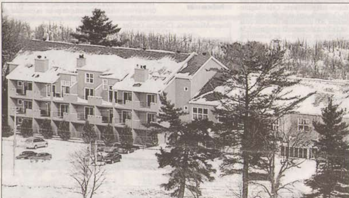
Gilbert Delvaux, propriétaire de l'Auberge Quilliams depuis l'été dernier, se dit ravi d'avoir pu compléter la première phase des rénovations, pour environ 400 000 $. D'autres travaux majeurs sont prévus dans cet établissement de Lac-Brome.
